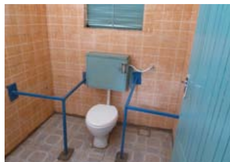
Une toilette conçue pour les utilisateurs handicapés dans l'établissement public d'assainissement construit par l'entreprise « Nanyuki Water and Sewerage Company » à Nanyuki au Kenya. PHOTO : EDWAR D KUNG'U, ARCHITECTE WSTF
