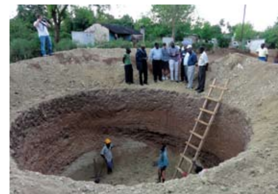
Construction de latrines biogaz dans le cadre du travail initié par le Devolution Trust Fund à Libuyu, Livingstone, en Zambie (novembre 2011).
